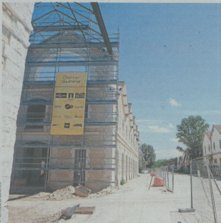
Les bâtiments sur la gauche vont abriter les prochains bureaux.
