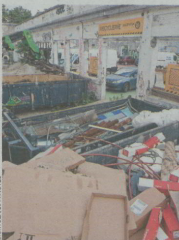
Une recyclerie juxta le chantier.
