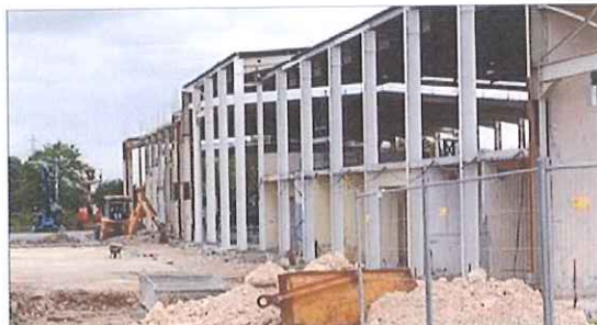
Personne autour du bâtiment à refaire. Il n'y a pas eu de visite
